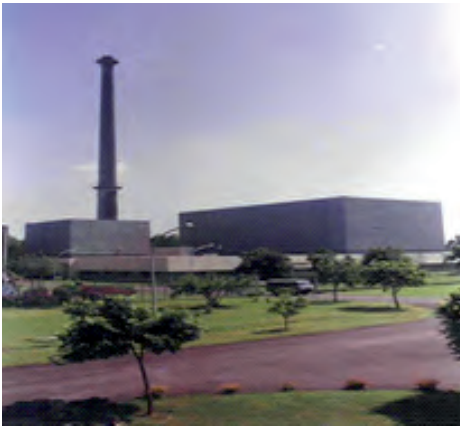
Waste Immobilisation Plant, Tarapur
